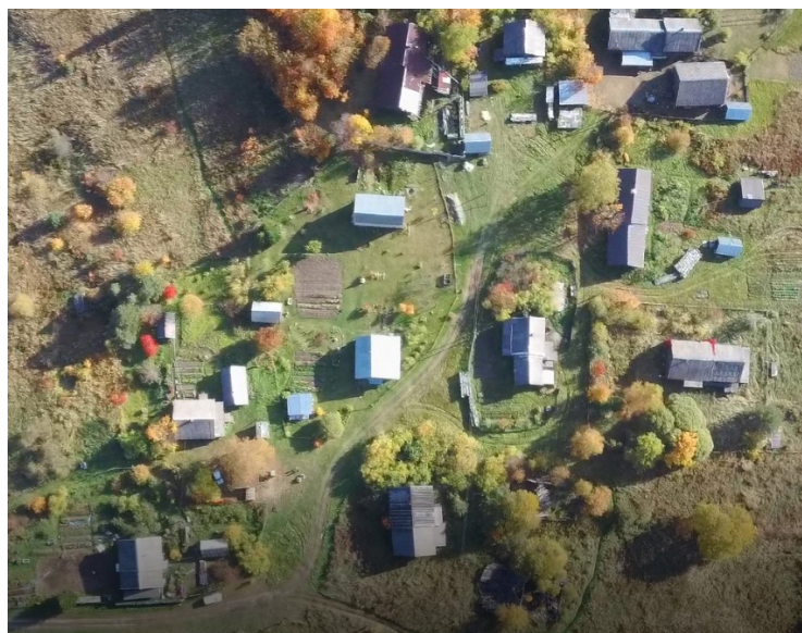
Рис. 15. Новостройки в деревне Дмитриево. Домики дачников Число дач соответствует числу домов в деревне ( R = 0,34 ). Дачники редко могли снять квартиру в двухквартирных домах ( R = -0,23 ). Из 254 изученных двухквар- тирных домов (508 квартир) лишь две квартиры использовались как дачи.
